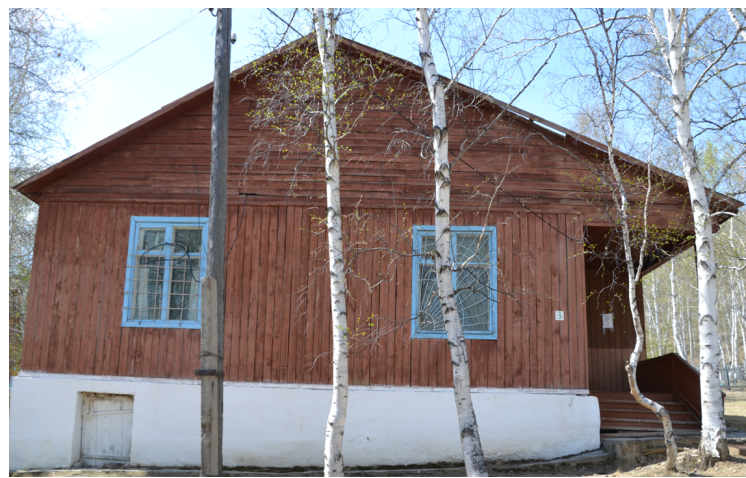
Здание ФАПа в селе Любовь
