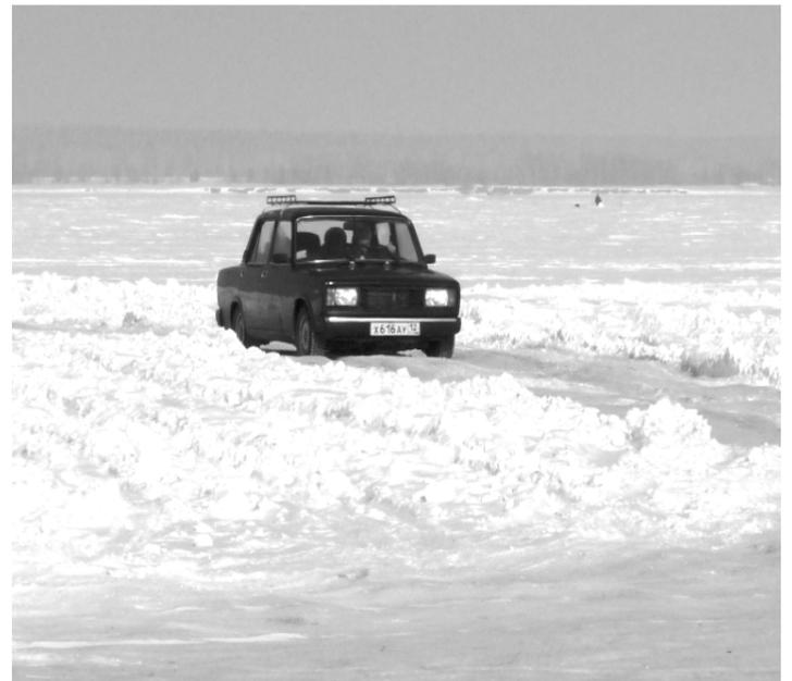
ТОЛЩИНА льда на ледовой переправе зависит от грузоподъемности автотранспорта - чем больше вес автомобиля, тем больше должна быть толщина льда. Обычно толщина льда составляет примерно 50-70 см. Такие переправы самые надежные и могут эксплуатироваться практически до марта.
